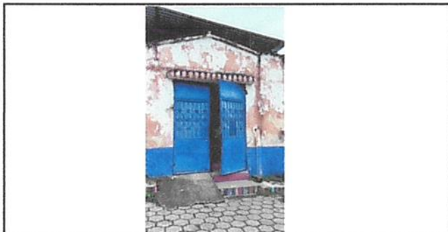
Foto 5: Reparación de portón de ingreso (lijado, pintura y bisagras) medida de 2.5*2mts.
