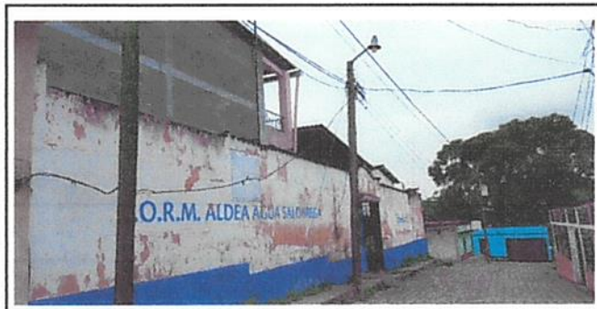
Foto 6: Suministro e instalación de arquiteja en tapial frente de la escuela.
