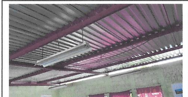
Foto 4: Sustitución del sistema eléctrico.
